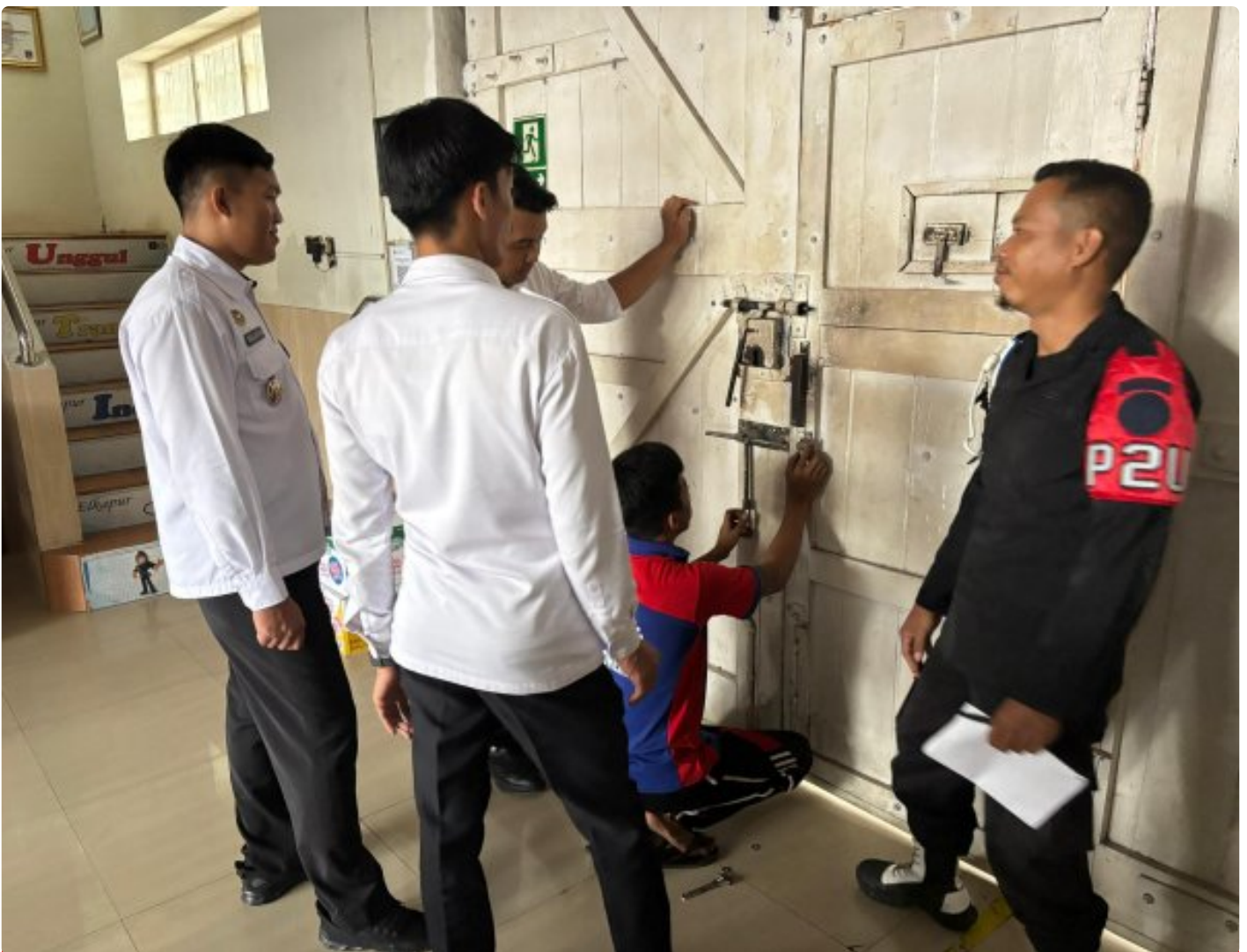
Garda Terdepan Keamanan, Lapas Narkotika Purwokerto laksanakan Perawatan dan Perbaikan Pintu Utama
